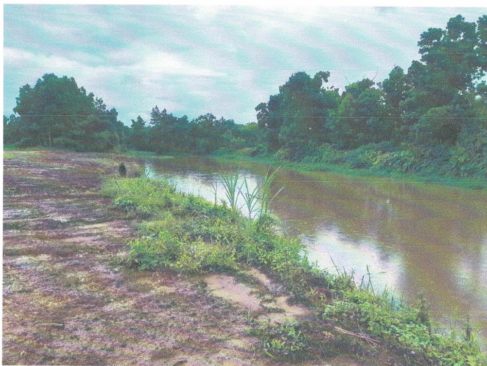
สภาพทั่วไปบริเวณที่ตั้งโรงสูบน้ำฯ
