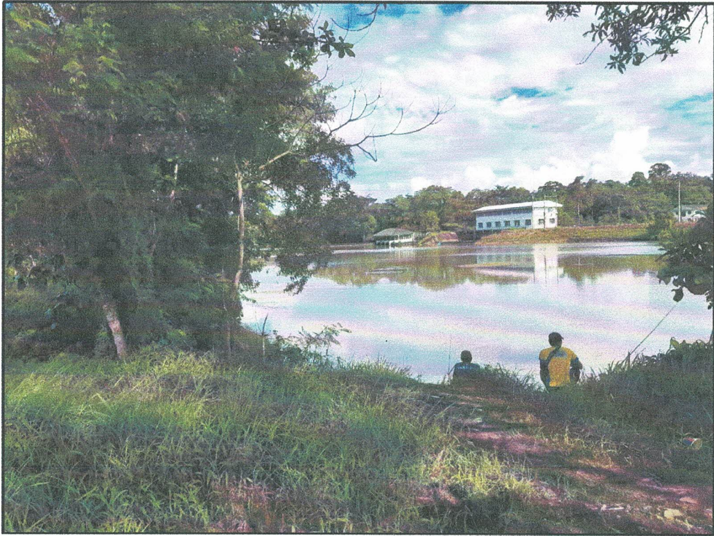
สภาพทั่วไปของสระประปา
