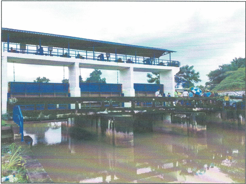
สภาพทั่วไปของประตูระบายน้ำคลองท่าพรุก
