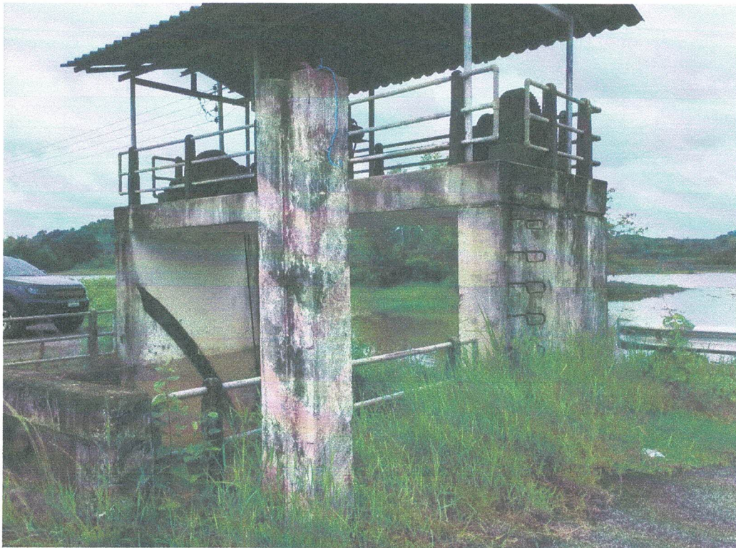
สภาพความชำรุดเสียหาย ของประตูประบายน้ำคลองร้างหาย
