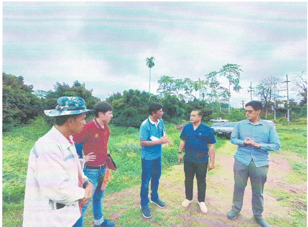
สภาพทั่วไปบริเวณจุดก่อสร้างโครงการฝายบ้านดินแดง
