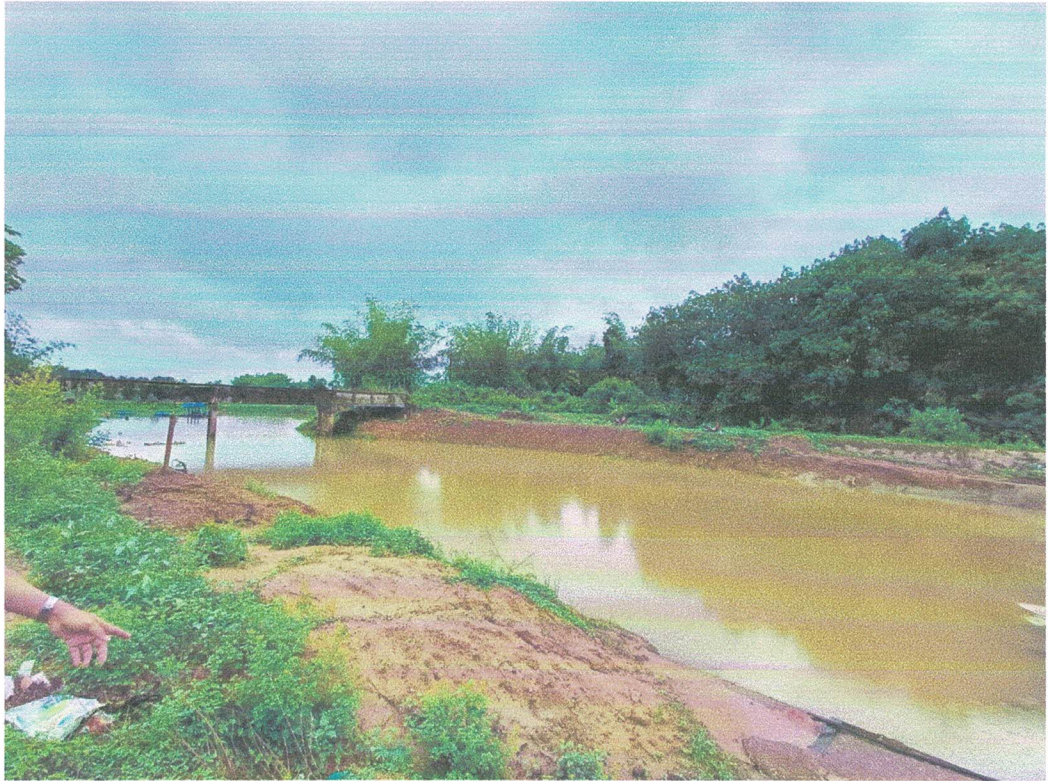
สภาพบริเวณด้านเหนือน้ำจุดที่จะก่อสร้างโครงการ
