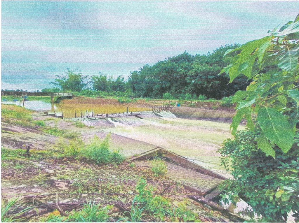
สภาพทั่วไปบริเวณจุดก่อสร้างโครงการฝายบ้านดินแดง
